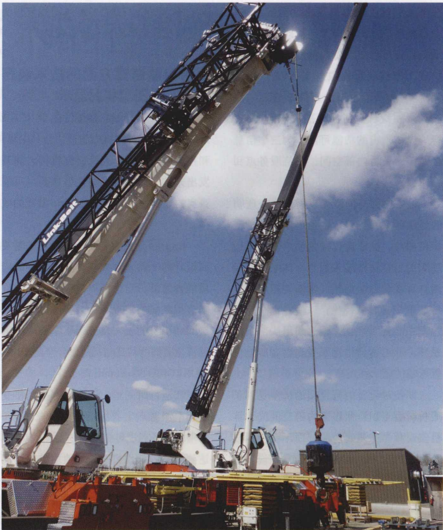
图 1 在位于 Kentucky 的 50 万 ft 2 厂区的地面上设立了 Link-Belt 施工起重机
