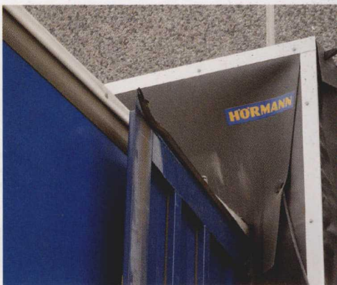
图 2 物资入库检验区的两道工业门补充了保暖门帘。这种门帘应能够让所有 Keppel 公司常用的载重车畅通无阻的进出库检验区，并保证室内不会受到穿堂风的影响、不会有热能损失
