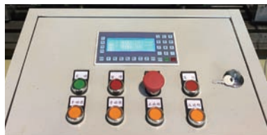
图2 电动机控制柜
