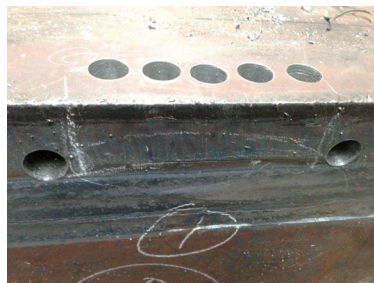
图6 止裂孔实物
