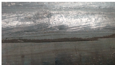
图2 层状撕裂实物
