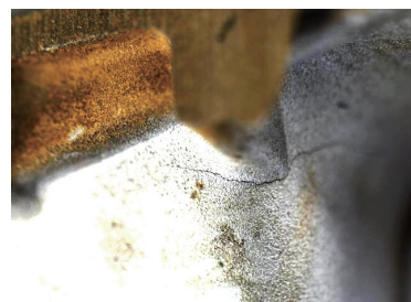
(b) 表面裂纹形貌
