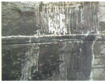
图2 原焊缝打磨
