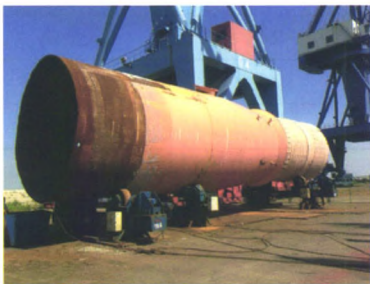
图1 返修焊接试验筒体
