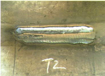
图4 返修焊焊缝成形
