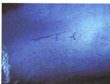
图2 上升管角焊缝出现的裂纹
