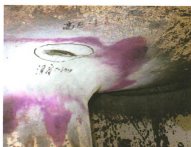
图1 打磨后的沟槽形貌
