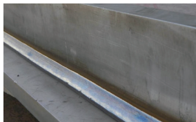
图24 焊缝成形
