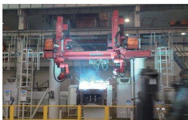
图11 现场机器人焊接
