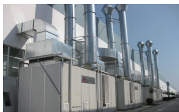
图19 组合式通风除尘空调机组
