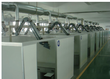
图9 工作间+吸气臂捕捉形式
