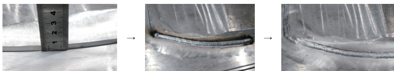
图8 焊接完成状态
