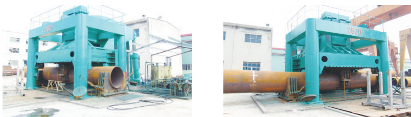
(b) 大口径钢管冷弯（油压机进行钢管弯曲）
