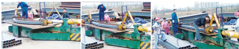
图9 钢管冷弯（拉弯工艺）
