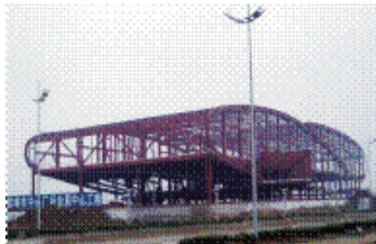
图16 带有贯口曲面桁架工程现场安装
