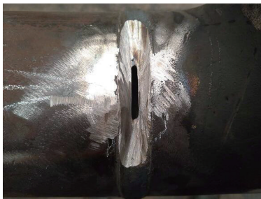
图5 根部缺陷的修复焊前
