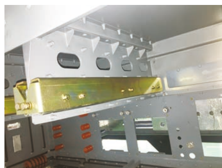
(b) 模块安装架环槽铆钉铆接
