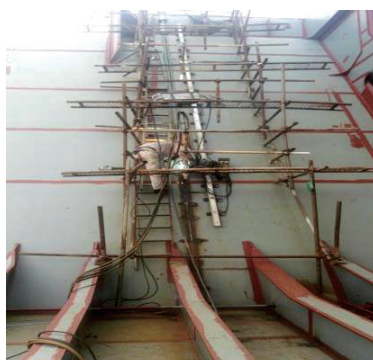
(a) 现场焊接
