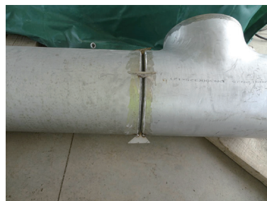
图3 对口定位焊
