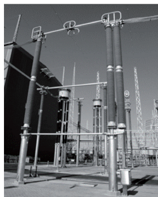
图1 400 kV高压直流隔离开关外观图
