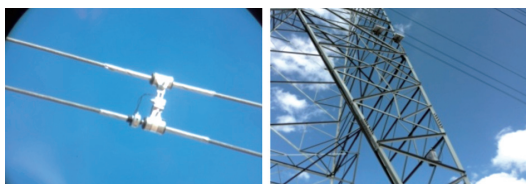
(a) 舞动监测装置安装 (b) 数据基站及太阳能板安装
