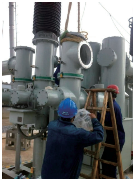
图4 更换绝缘子密封圈
