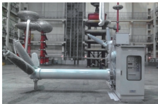
图6 126 kV GIS用套管型式试验
