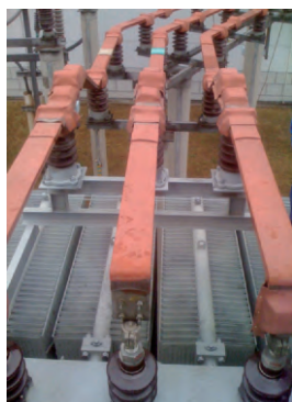
图7 套管铜排软连接
