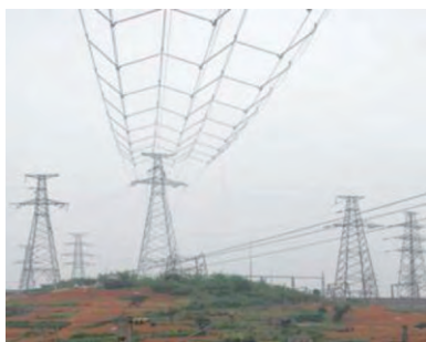
图2 承力索护网现场应用图
