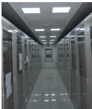
图1 “前接线、前显示” 预制舱
