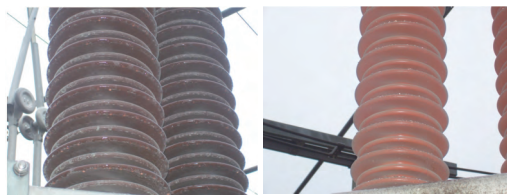
图2 未喷涂过PRTV涂料与涂过PRTV涂料的瓷绝缘子
