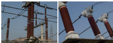
图1 喷涂过PRTV防污闪涂料的220 kV设备绝缘子可见光图
