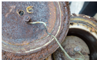
图3 A相电压互感器密封罩与连接线
