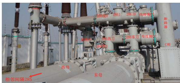
图3 286间隔回路电阻测试图
