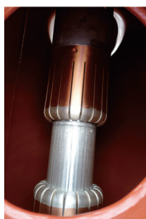
图8 断路器合闸状态
