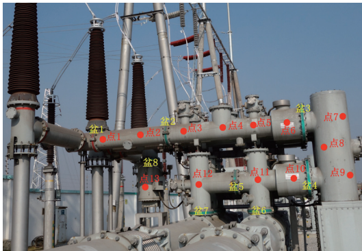
图2 286间隔局放检测布置图
