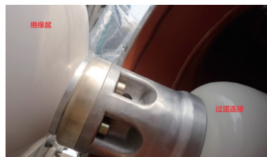
图6 绝缘盆与过渡连接
