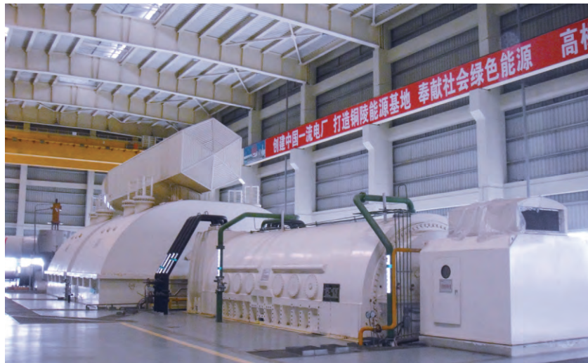
© 铜陵电厂国产1000 MW超超临界参数机组顺利安装投运
