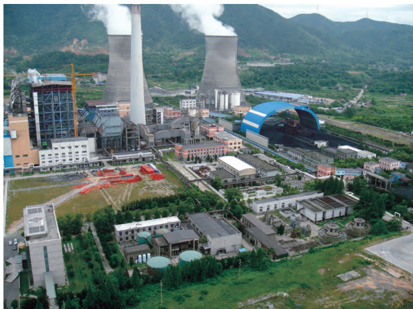
© 铜陵电厂EPC工程项目全景
