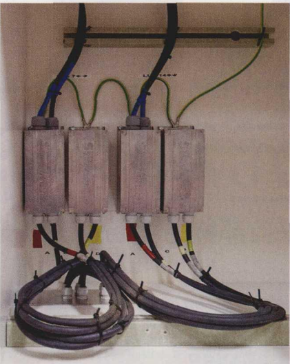
图 4 无接触式 Movitrans 能源供给装置的供电执行元件。
