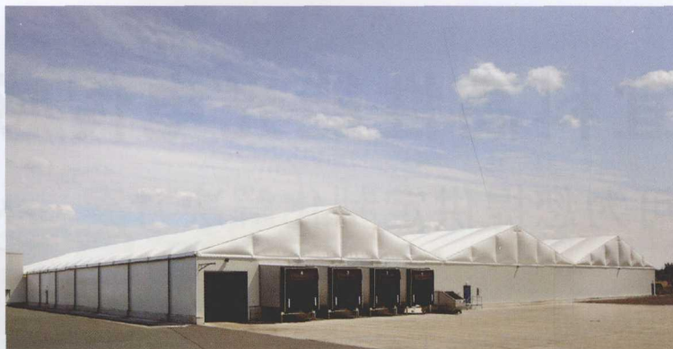
图 3 Röder 公司能够为用户提供最大跨度至 40 m 的工业帐篷，这些工业帐篷都可以按照每间长度 2.5 m 及 5 m 的尺寸无限制的扩展
