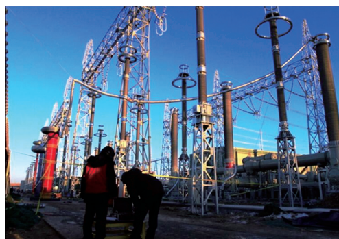
(a) 母线对接前试验
