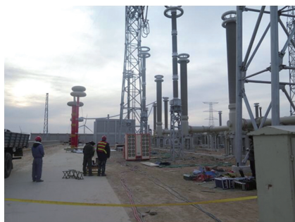
(b) 母线对接后试验
