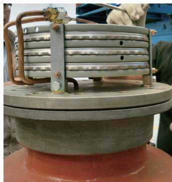
图7 224-9 C相CVT金属膨胀器
