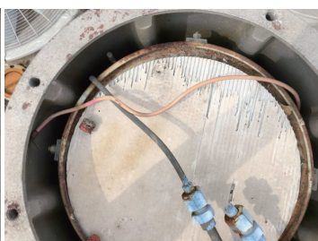
图5 下节顶端膨胀器
