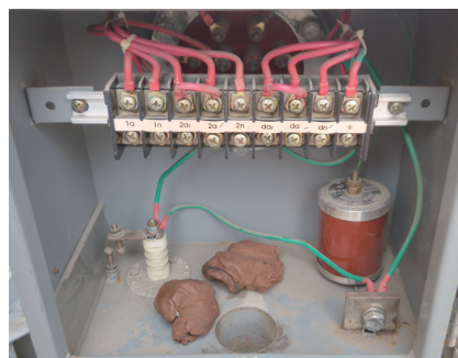
图3 224-9 C相电容式电压互感器二次端子盒
