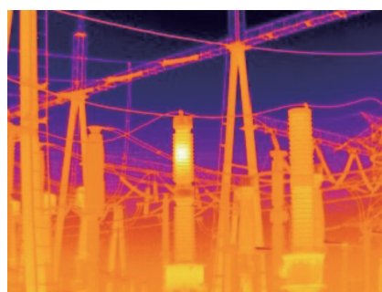
图2 224-9 C相CVT器红外热成像图谱
