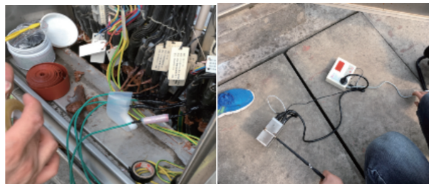
(c) 热缩带包裹聚四氟乙烯薄膜
