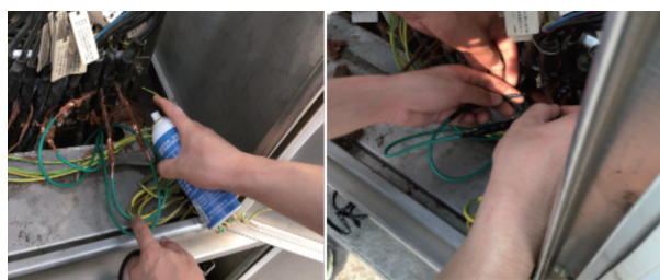
(a) 使用铜线连接后 喷涂导电保护液
