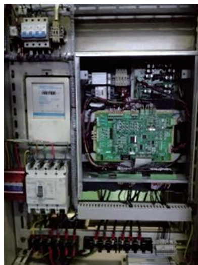
图9 电气控制柜组装图
