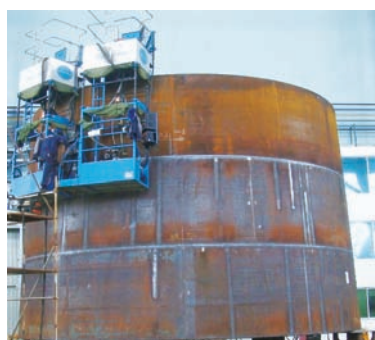
图1 筒体埋弧焊横焊
