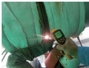
图2 手工氩弧焊打底
