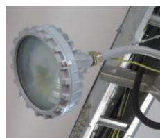
图1 LED防爆灯安装图
