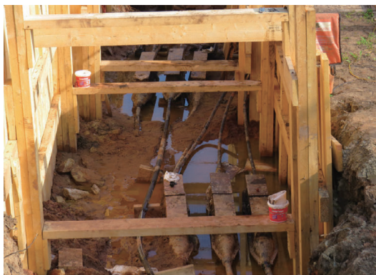
图5 将分段电缆连接在一起的安装接头
