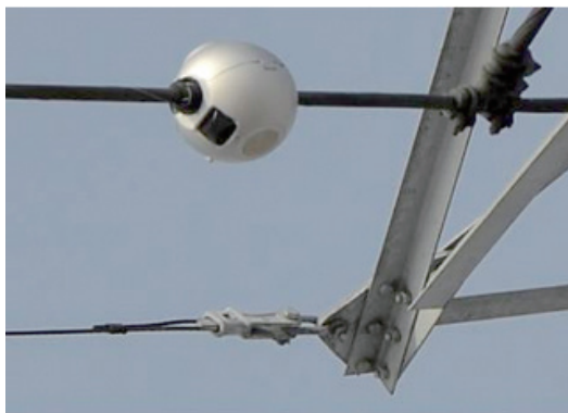
图2 路动态增容现场收集装置
