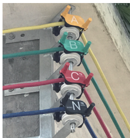
图3 电线颜色标配产品颜色
