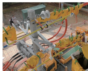
图8 分流线固定装置现场操作图
