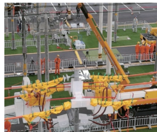
图1 绝缘屏障导线固定法的现场示意图
