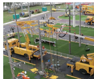
图2 分流导线分流固定法的现场示意图
