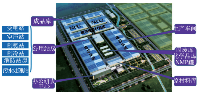
图3 智能化动力电池工厂的组成
