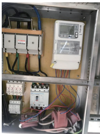
图3 配电柜接线
