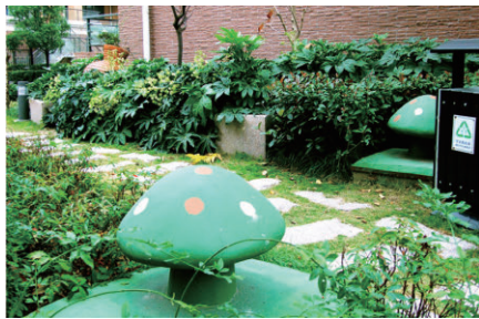
图1 全地埋式变电站（绿色蘑菇为通风孔）
