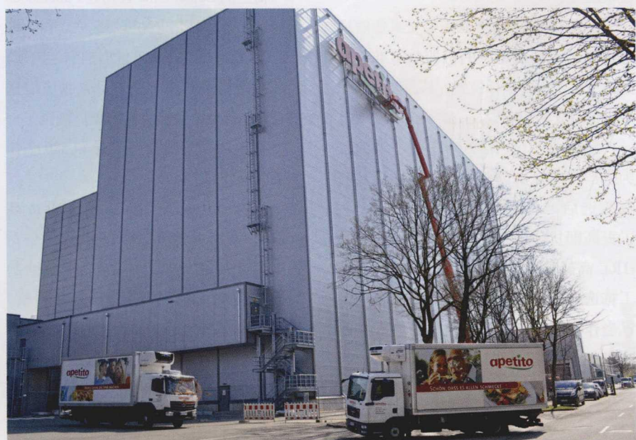
图 1 Apetito 公司最新的高架立体冷库的货架长度 74 m、宽度 30 m、高度 43 m，是联邦德国最大的冷库之一
