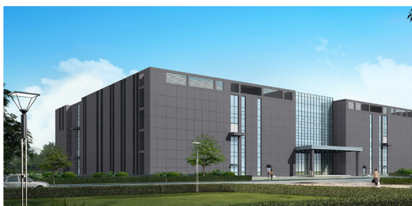
图2 某云数据中心
