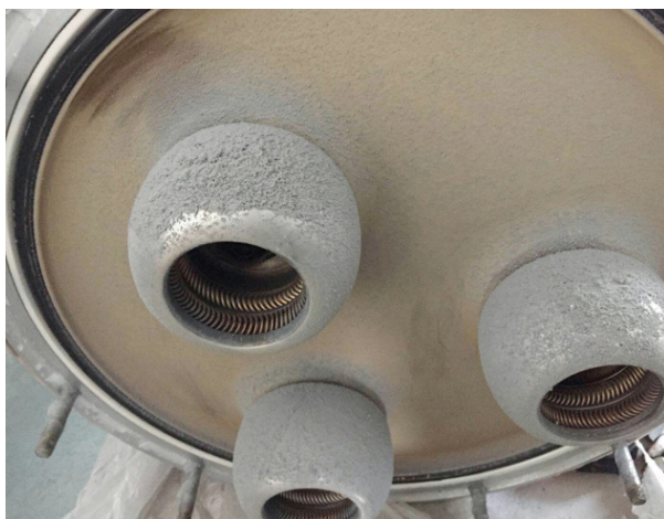
图11 152断路器静触头
