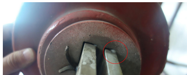
(f) 穿墙套管接线板及端部(户外)
