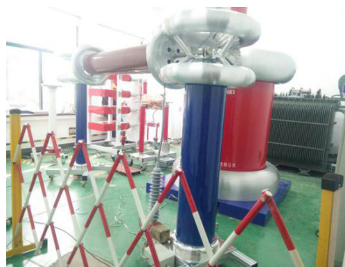
图3 联合加压试验装置现场接线
