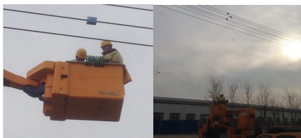
图11 设备安装过程 Fig. 11 Device installation process
