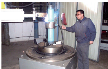
图3 采用自动MAG焊进行法兰-固定套环缝焊接
