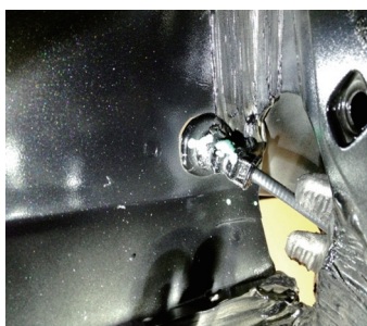
图6 某车型前仓漏雨问题
