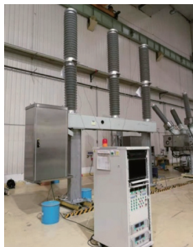
图4 126 kV高压断路器特性测试图
